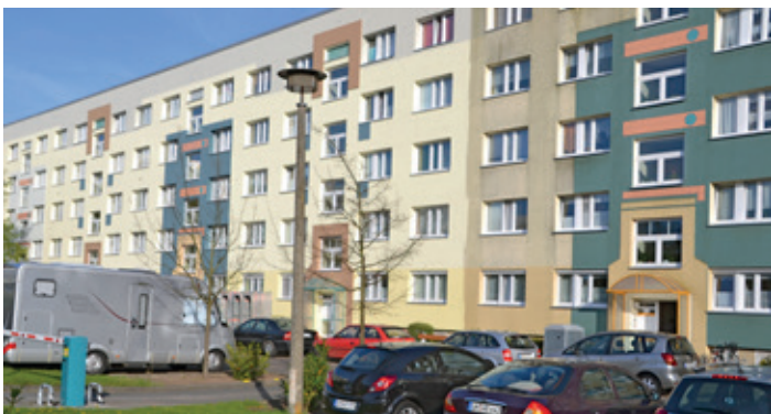
2015 erhielten die Gebäude Am Kanal 1 – 10, 11 – 15 und Vierrader Straße 1 – 17 nach der Erstsanierung in den Jahren 2000/2001 u. a. einen neuen Farbanstrich. Das Bild zeigt den krassen Unterschied vor und nach der Renovierung am Beispiel Am Kanal 1 – 10.
