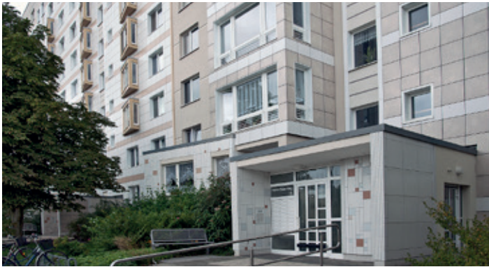
Küchenerweiterungen im Hanns-Eisler-Weg. Auch hier wurde im bewohnten Zustand umgebaut. Eine besondere Herausforderung für Mieter und Vermieter. Aber das Ergebnis war diese Anstrengungen wert. Die hier wohnenden Mieter wissen den Platzgewinn sehr zu schätzen. Die nachgerüsteten Erdgeschosshaltestellen des Aufzuges gewährleisten einen barrierefreien Zugang – in Zeiten des demografischen Wandels, eine nachhaltige Investition in die Zukunft.
