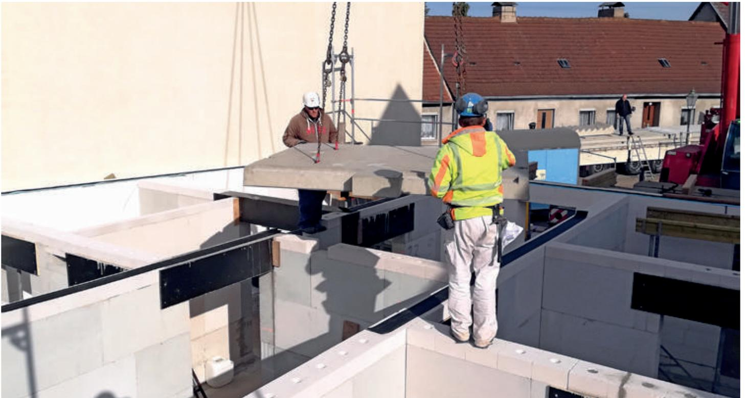
Präzision, Fingerspitzengefühl und ein gutes Auge sind gefragt bei den Mitarbeitern der Bau Casekow GmbH, die hier die Geschossdecken aufsetzen.
