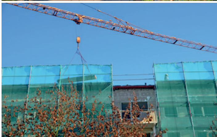
Der Hub der ersten Platte am J.-Marchlewski-Ring 2-16 am 14. November 2016 läutete gleichzeitig den Beginn des dritten und letzten Bauabschnittes der Regenbogensiedlung Zetkinstraße ein. Dies wurde mit einer kleinen Baustelleneröffnung, an der neben dem Bürgermeister Herrn Polzehl auch die Wohnbauten Geschäftsführer Herr Wilke und Herr Lienert sowie die Planer, Wohnbauten Mitarbeiter und die Abrissfirma 3S teilnahmen, gewürdigt.
