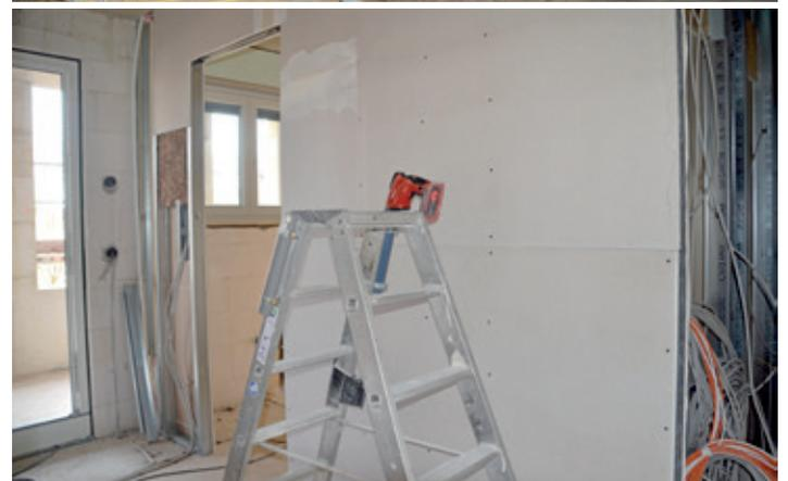
Das Stellen der Trockenbauwände in den Wohnungen ist in vollem Gange. Vorher wird die Elektroinstallation vorbereitet, so verschwinden die Leitungen im Trockenbau.
