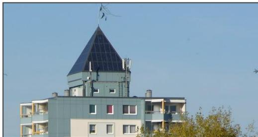
Seit Oktober 2005 wird auf dem Gebäude eine Photovoltaikanlage genutzt, die aus 3 Segmenten des Typs Sunny Boy SWR SB 2500 besteht. Die Nennleistung der Anlage beträgt 7500 VA.
