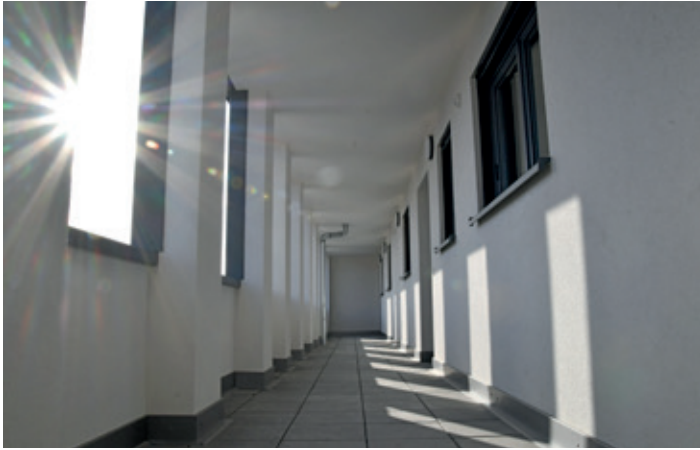
Alle Wohnungen sind über einen Laubengang erschlossen.
