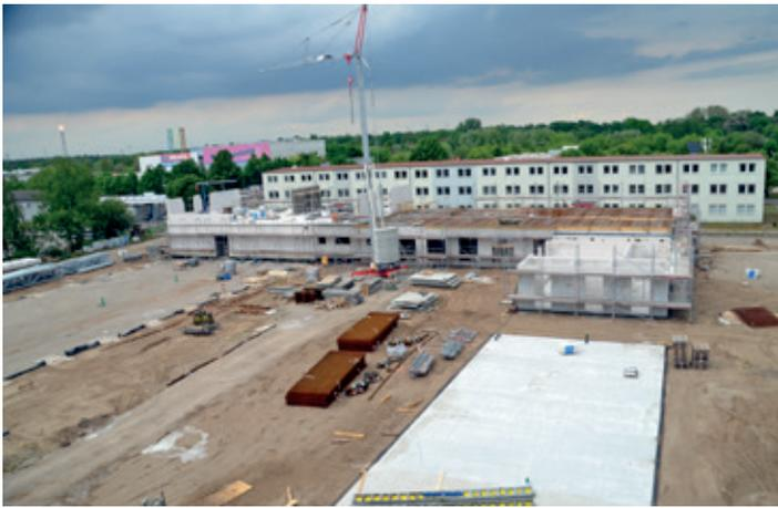
Blick über die Baustelle vom Schlauchturm aus. Im Vordergrund ist die Bodenplatte des Verbindungsbaus zwischen dem Funktionsgebäude und dem Schlauchturm zu erkennen.
