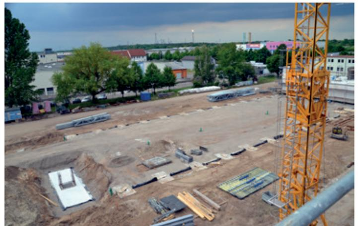
Die Fundamente für die Fahrzeughalle sind gegossen und für die Kfz-Werkstatt ist die Fahrzeug-Grube fertig. Sie wirkt neben der riesigen Dimension der Halle eher winzig.
