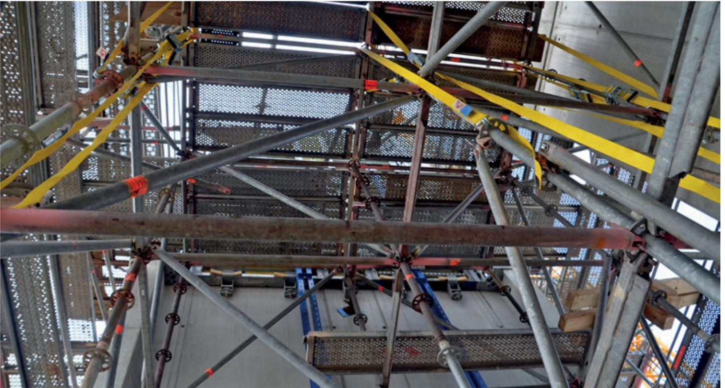
Blick in den im Bau befindlichen Schlauchturm, der einmal 25 m hoch sein wird. Die Rüstung ist gleichzeitig Stütze für die Schalttafeln und wächst stetig mit. Der Bau des Turmes folgt einer ausgeklügelten Technologie.
