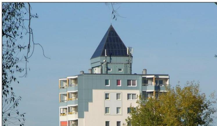
Seit Oktober 2005 wird auf dem Gebäude eine Photovoltaikanlage genutzt, die aus 3 Segmenten des Typs Sunny Boy SWR SB 2500 besteht. Die Nennleistung der Anlage beträgt 7,8 kWp.
