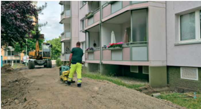
M.-Curie-Straße 1 – 5: Die Baustraße an der Rückseite des Gebäudes ist bereits fertig, die Gründungsarbeiten für die Kellerzugänge an der Rückseite des Gebäudes beginnen demnächst. Die Regen- und Trinkwasserleitungen werden neu verlegt.
