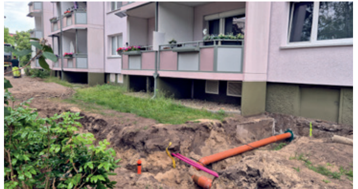
M.-Curie-Straße 1 – 5: Die Baustraße an der Rückseite des Gebäudes ist bereits fertig, die Gründungsarbeiten für die Kellerzugänge an der Rückseite des Gebäudes beginnen demnächst. Die Regen- und Trinkwasserleitungen werden neu verlegt.
