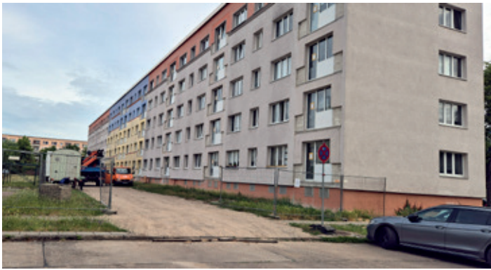
Heinersdorfer Straße 17 – 31: Die Demontage der alten Balkone ist bereits erfolgt, die Strangsanierung im Gebäude fast abgeschlossen und der Austausch der Fenster hat begonnen.
