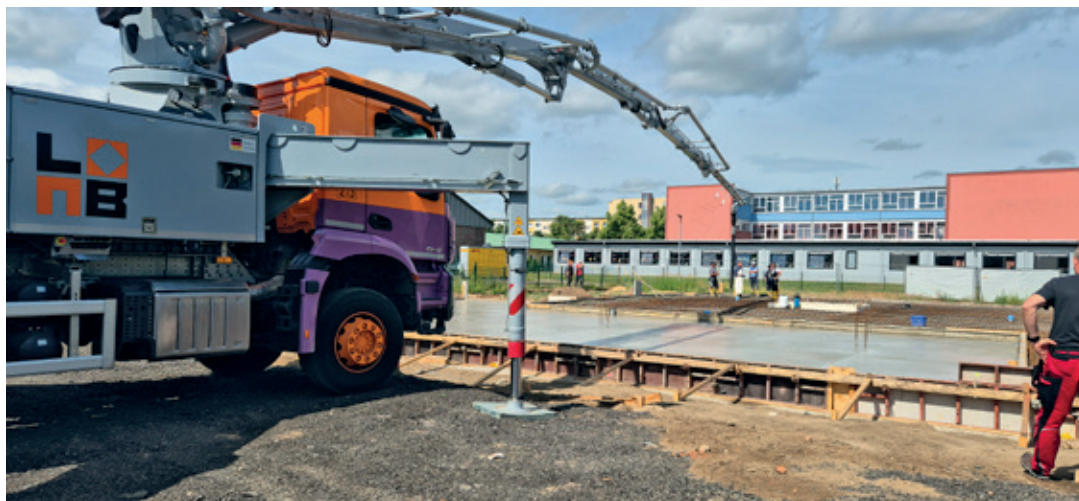
Für das Gießen der Bodenplatte fahren die Betonmischer im Minutentakt auf die Baustelle der Weißen Villen.
