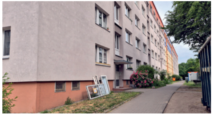
Heinersdorfer Straße 17 – 31: Die Demontage der alten Balkone ist bereits erfolgt, die Strangsanierung im Gebäude fast abgeschlossen und der Austausch der Fenster hat begonnen.
